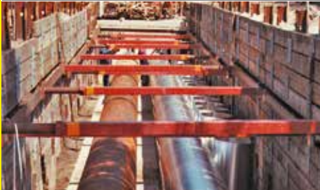
Verbau mit Stahlgurtung
