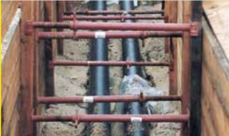
Verbau mit Stahlgurtung
