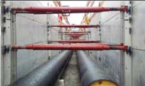
Alu-Kammerplattenverbau GIGANT
