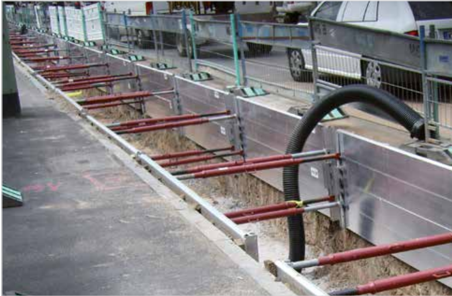
Alu-Leichtverbau GIGANT Das ideale System für den innerstädtischen Bereich.
