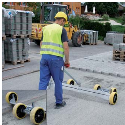
LF-125/215. links unten: Rad-Höhenverstellung
